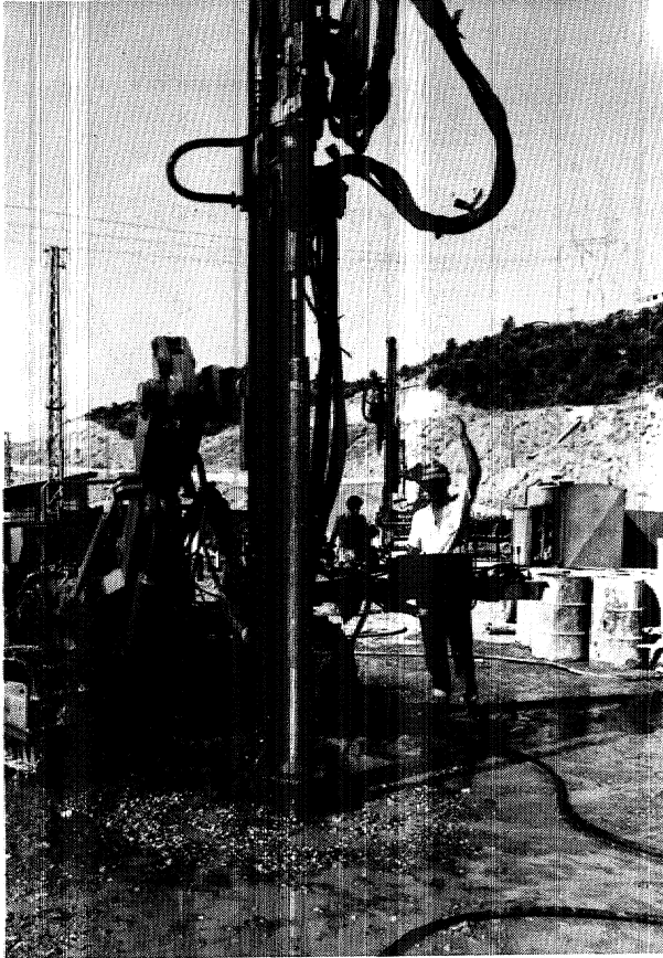
Foto 1- Alüvyonda yapılan sondajdan görünüş
